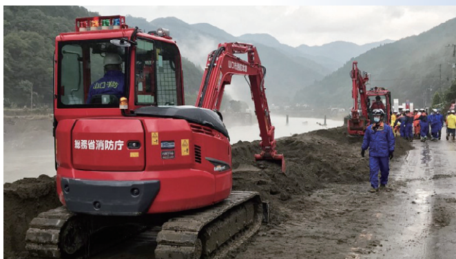
熊本県球磨郡球磨村搜索活動状況（提供：下関市消防局）
